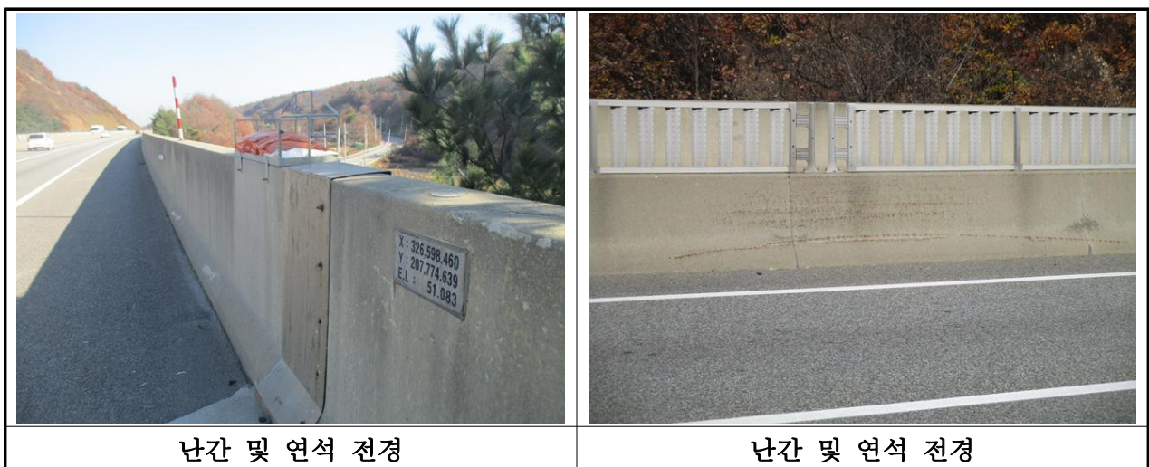
【사진 3.20】 난간 및 연석 전경
