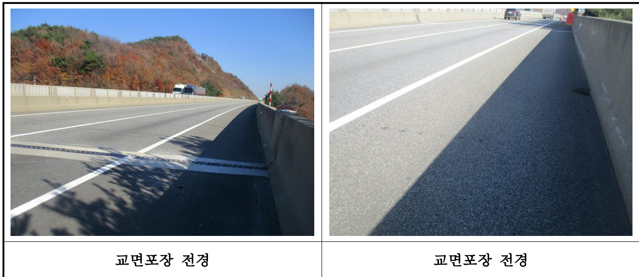
【사진 3.17】 교면포장 전경
