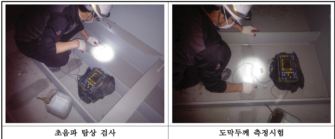
【사진 3.43】 강재 내구성조사 전경
