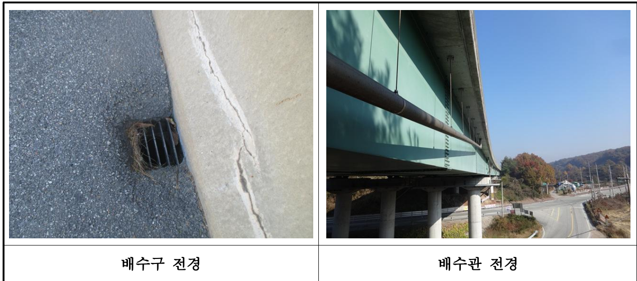
【사진 3.19】 배수구 및 배수관 전경
