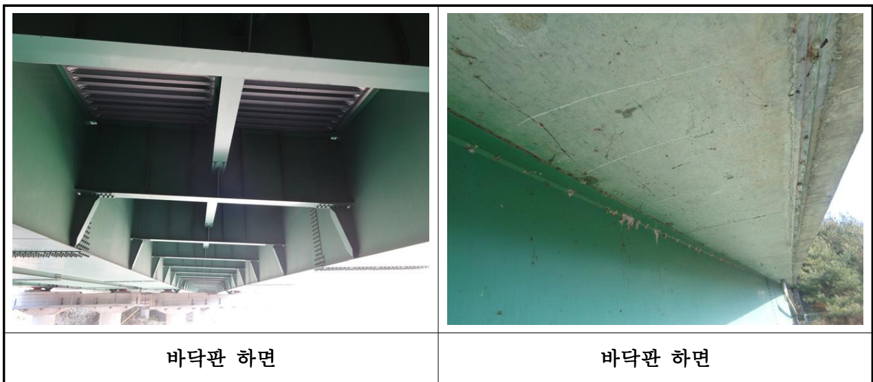
【사진 3.2】 바닥판 전경
