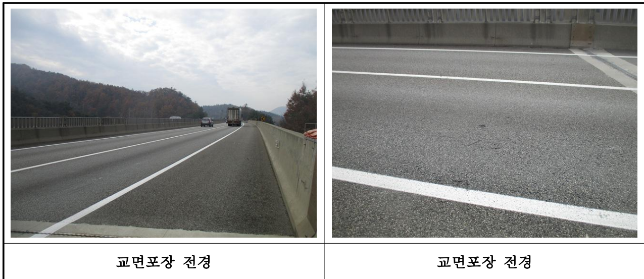
【사진 3.37】 교면포장 전경
