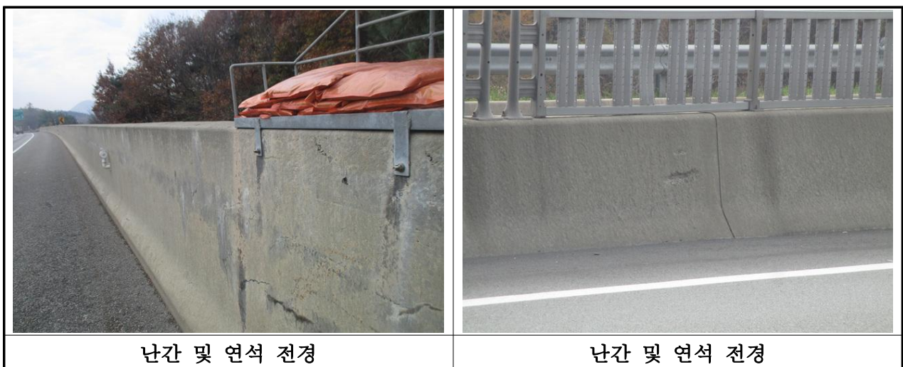
【사진 3.40】난간 및 연석 전경
