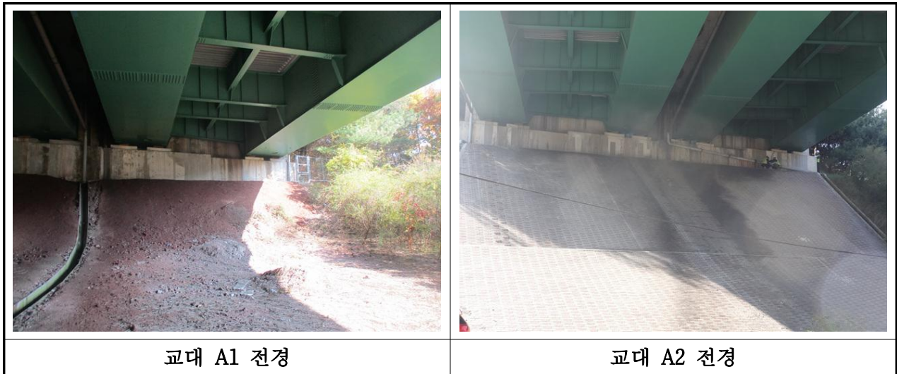
【사진 3.8】 교대 전경
